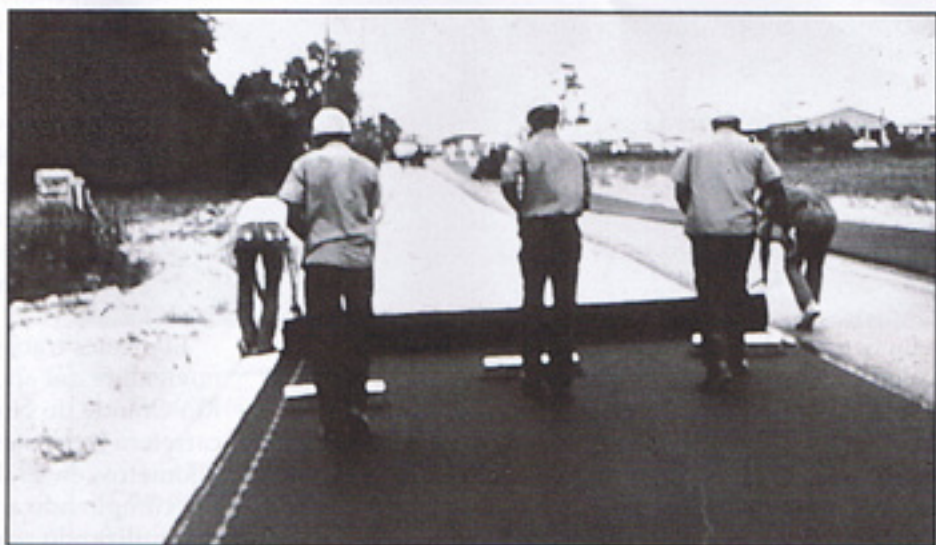
Después de cortar las arrugas en la tela, es importante aplicar más adhesivo a las áreas cortadas.
